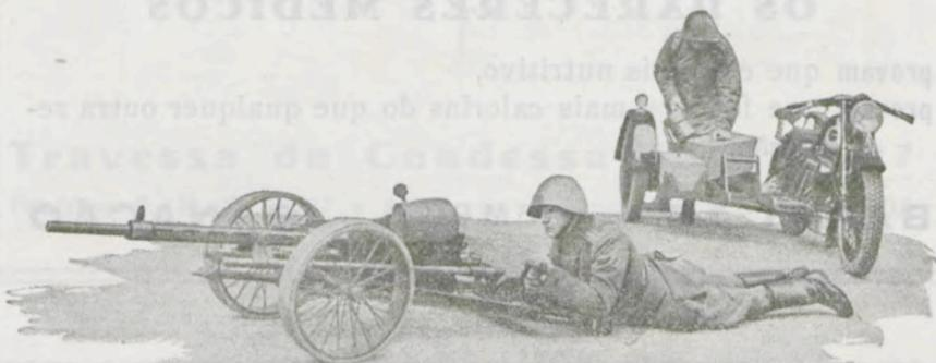
O canhão automático **Madsen** de 20<sup>mm</sup>, sobre «side-car», pode fazer fogo montado sobre este, ou no terreno, sobre o reparo a que está permanentemente ligado
