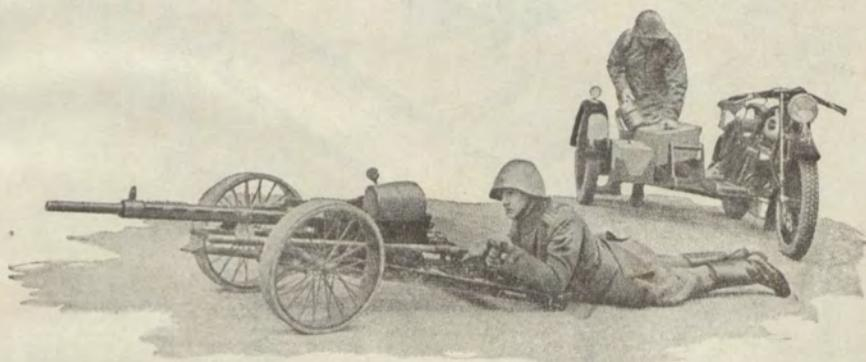
O canhão automático **Madsen** de 20<sup>mm</sup>, sôbre «side-car», pode fazer fogo montado sôbre êste, ou no terreno, sôbre o reparo a que está permanentemente ligado
