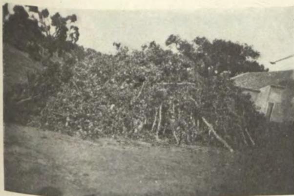
*Quatro camionetes e um carro tanque de gasolina, completamente encobertas com ramos de árvores da região. Esta camouflagem apresenta-se à observação aérea, com o aspecto de uma árvore.*
