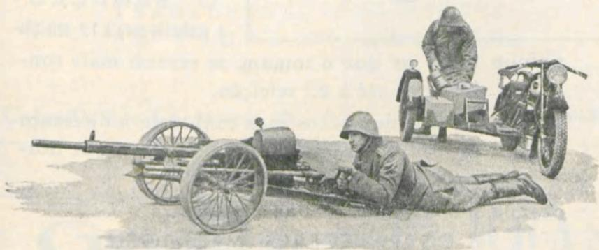
O canhão automático **Madsen** de 20<sup>mm</sup>, sôbre «side-car», pode fazer fogo montado sôbre este, ou no terreno, sôbre o reparo a que está permanentemente ligado
