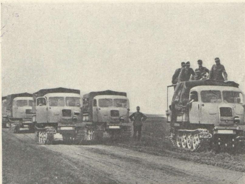
*Novos modelos de carros-rebocadores alemães, construídos especialmente para a campanha da Rússia. Este rebocador recém-criado, distingue-se pela sua grande facilidade de movimentos através dos maiores lamaçais e pântanos*
