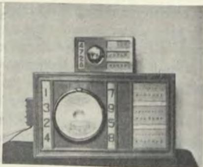
Aparelhos para avaliação da resistência ao deslumbramento, sendo o modelo grande do Lab. do G. C. T. A. e o pequeno dos Postos Móveis dos C. I. A.
