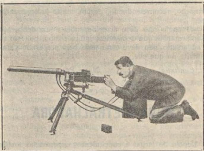
O ultimo modelo, que foi o apresentado para se fazerem aquellas experiencias a que já nos referimos, peza sómente 11 kilos, sendo mais leve do que qualquer dos outros modelos postos em concorrência. O tripê, de typo ligeiro, peza 15 kilos, o que dá um total de 26 kilos para a arma e suporte, o que é o bastante para se mostrar o quanto é facil o seu transporte.
