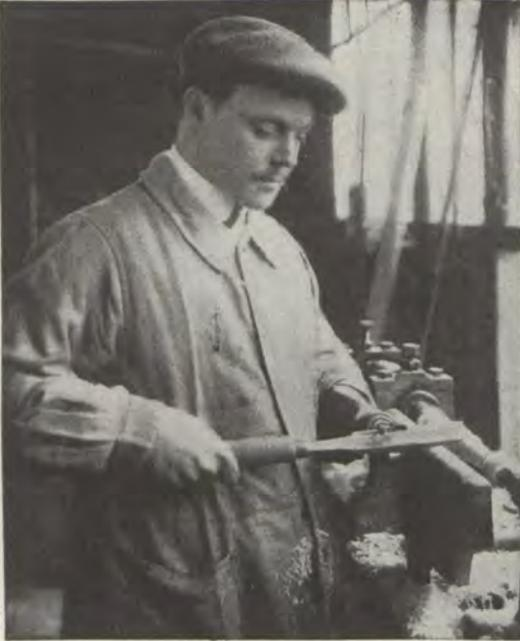
FIG. 233. — Main artificielle du D<sup>r</sup> Kresser pour tourneur sur bois.
