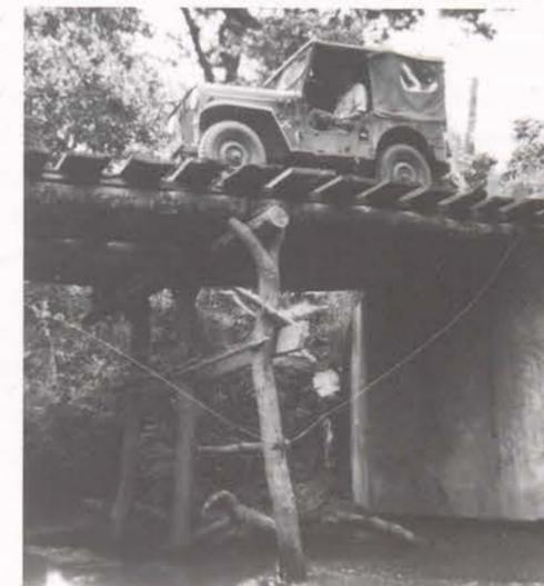
Frequentemente, reconstruíam-se pontes para, passado um dia ou dois ou mesmo algumas horas, ter que se improvisar uma passagem, pois já tinha sido destruída ou incendiado o seu tabuleiro.
