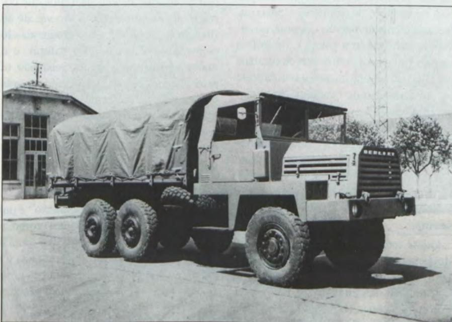
dimensões são as seguintes: comprimento total - 7,28 m; largura total - 2,4 m; altura total com capota - 3,3 m.
