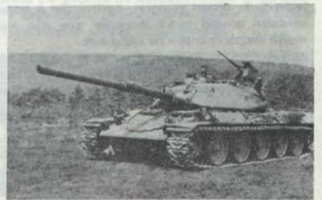
O "STB-1", alto e baixo, conforme a acção da sua suspensão (2,25 m-2,00 m).
