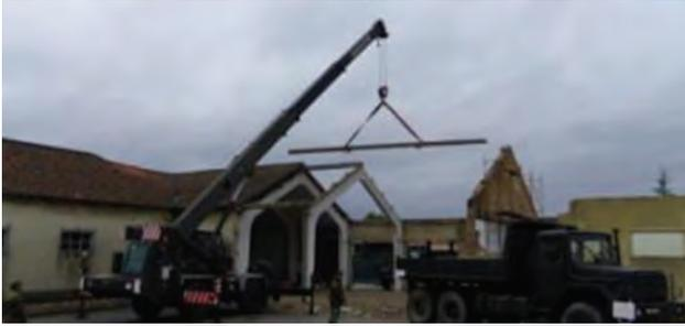
Demolição de tetos falsos, paredes divisórias simples e elementos de suporte vertical (paredes resistentes e pórticos de betão armado).
